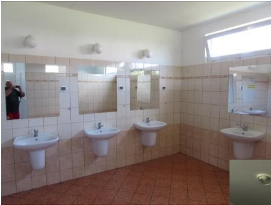
Und so sieht das neue Sanitärgebäude aus.
