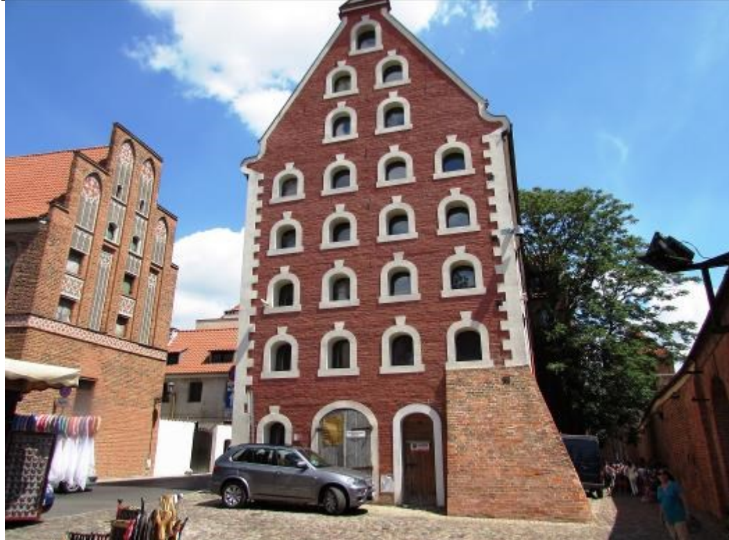
Und noch ein Getreidespeicher.
