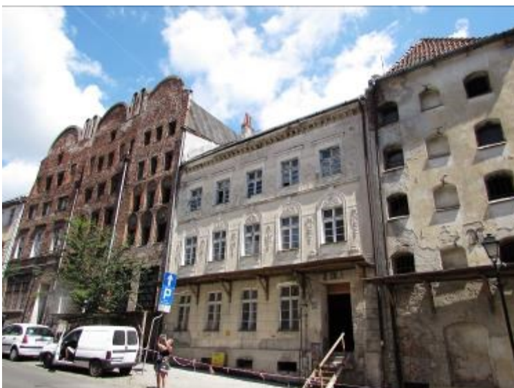
Gebäude, welche noch auf die Restaurierung warten.
